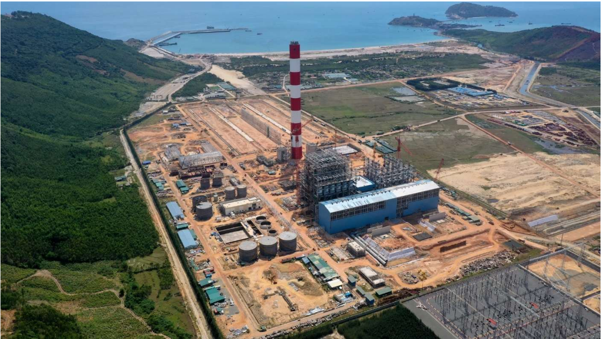
Nhà máy Nhiệt điện Quảng Trạch 1
