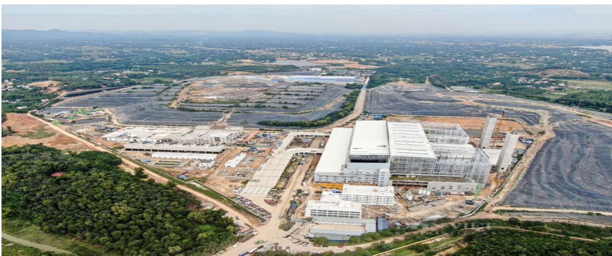
Nhà máy nhiệt điện rác Sóc Sơn
