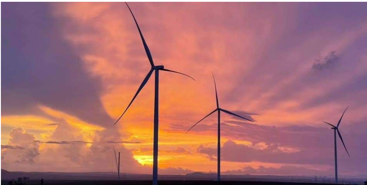
Nhà máy Điện gió Ia Pết Đăk Đoa 1, 2
