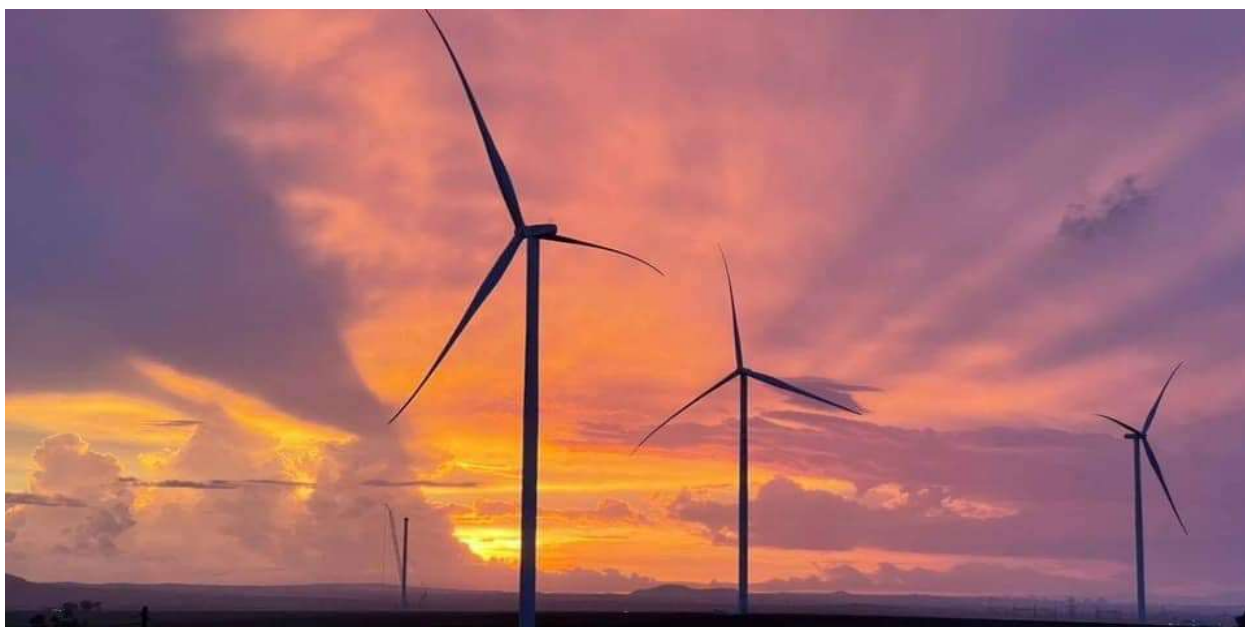
Nhà máy Điện gió Ia Pết Đăk Đoa 1, 2 (khánh thành ngày 14/01/2022)
