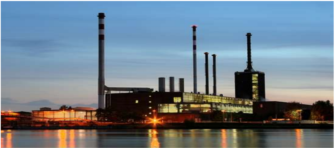
Nhà máy nhiệt điện Thái Bình 2
