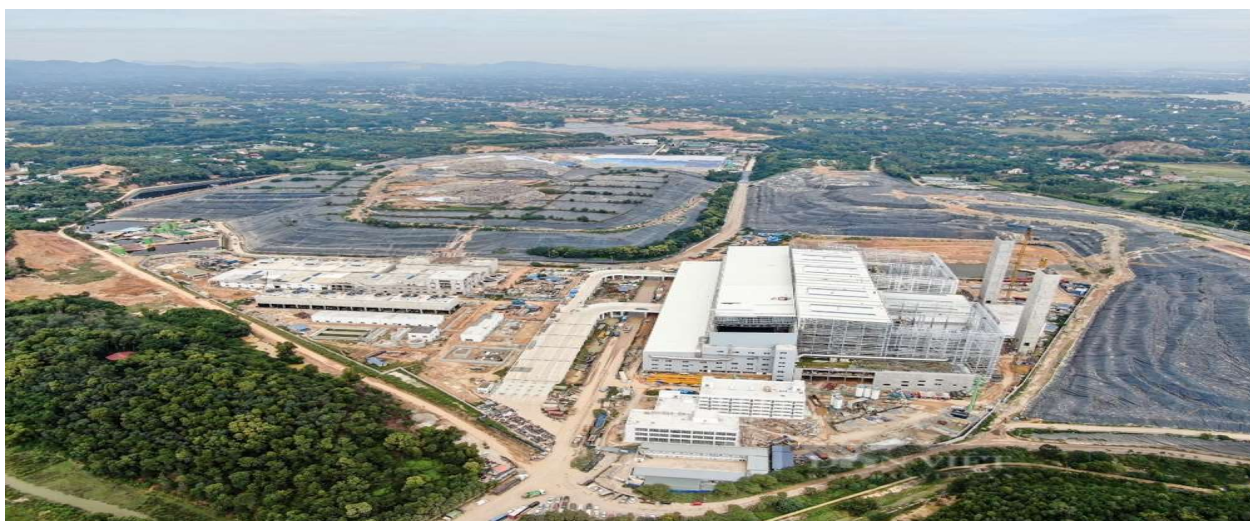
Nhà máy nhiệt điện rác Sóc Sơn
